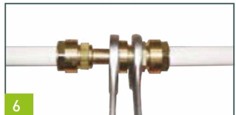
Fixez enfin l'écrou du milieu (marqué d'une rainure) sur le corps à longueur réglable.
