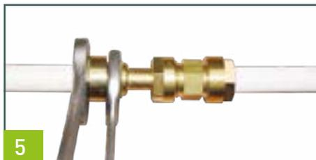
Vissez les écrous et serrez-les jusqu'à ce que le manchon union dépasse max. 1 à 2 mm de l'écrou. Pendant le serrage, il est recommandé de maintenir le corps en utilisant une autre clé pour éviter qu'il ne pivote.
